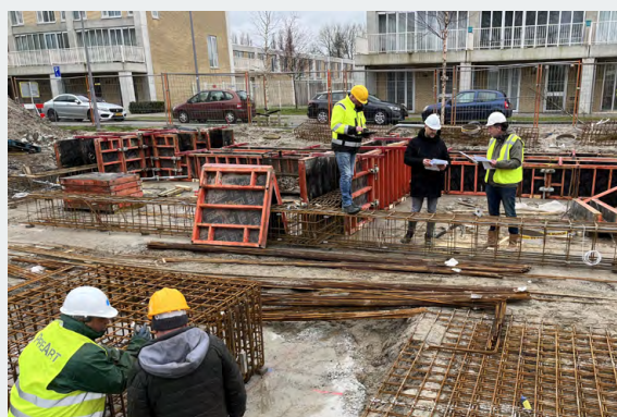
Rotterdam Wildenburg funderingswerkzaamheden en controle wapening
